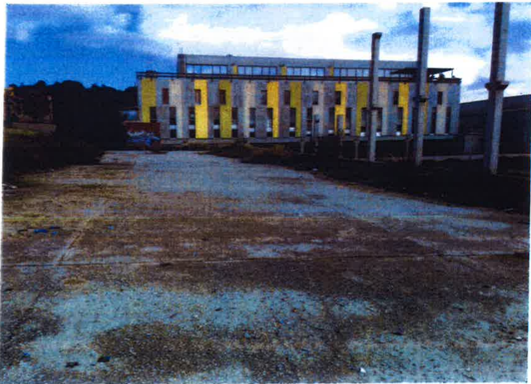
Imagen 18 ; zona de hormigón en la zona sur de la parcela.
