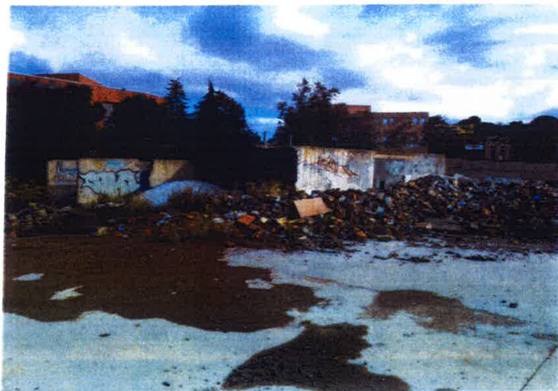
Imagen 10 ; construcción sin parte superior y explanada de hormigón en la parte norte de la parcela.
