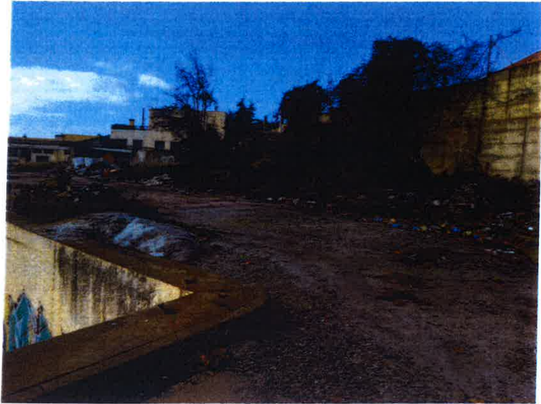
Imagen 11 ; talud de tierra en el muro que da a Camino de Ca la Madrona.
