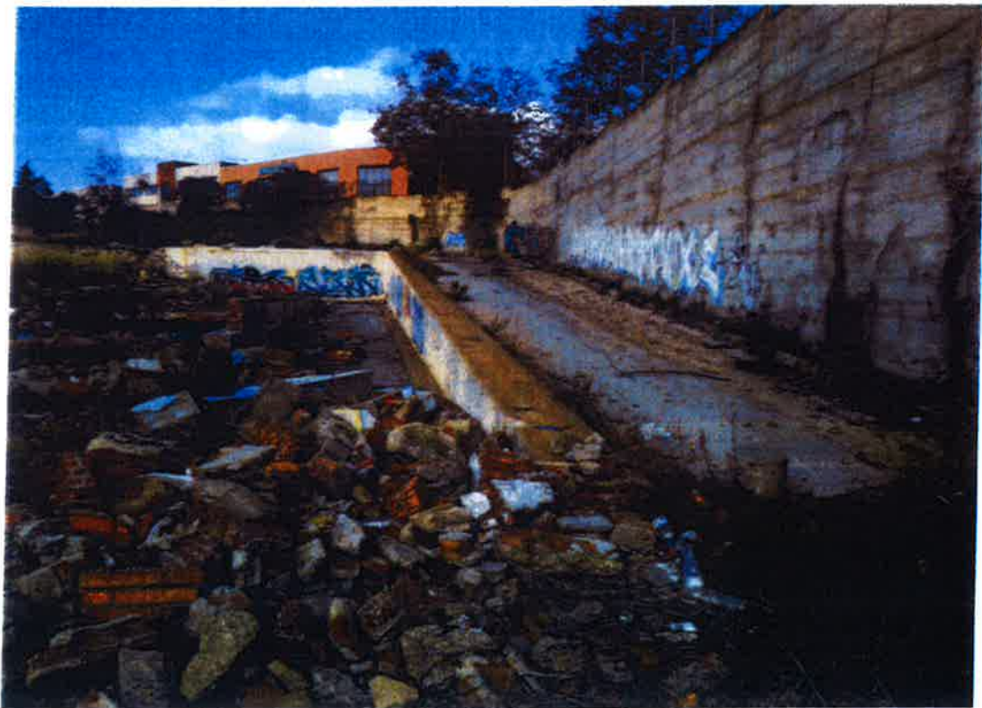
Imagen 20 ; rampa de hormigón paralela al muro de la calle Fonería que da a la explanada de hormigón de la zona norte.
