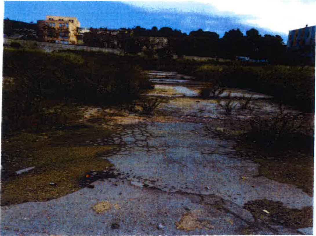
Imagen 17 ; zona de hormigón en la entrada de la parcela.
