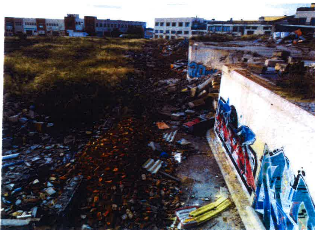
Imagen 22 ; vista general de la parcela desde la parte superior de la explanada de hormigón de la zona norte.
