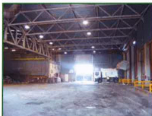
1. Zona de recepción y descarga de residuos
