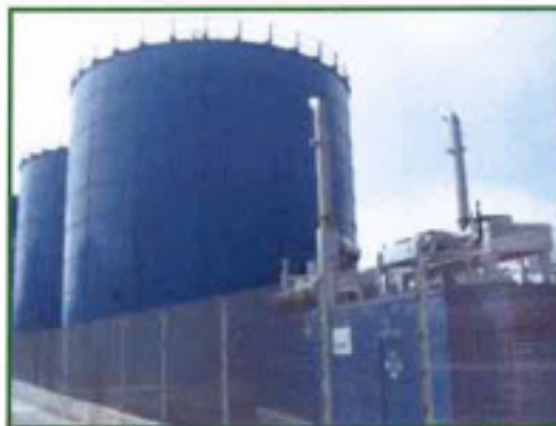
8. Digestores/Motores Cogeneración
