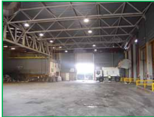
1. Zona de recepción y descarga de residuos
