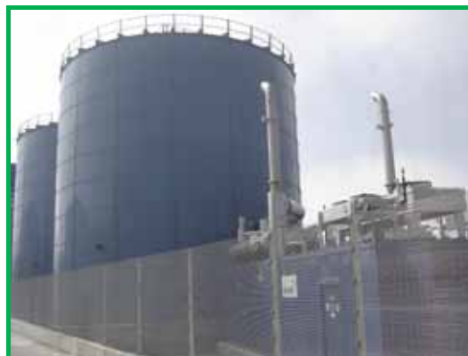
8. Digestores/Motores Cogeneración
