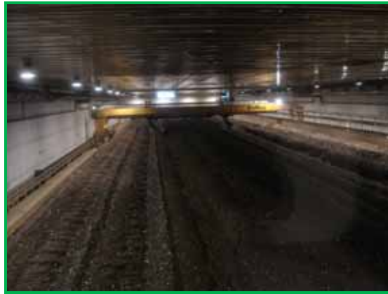
9. Reactor de bioestabilización
