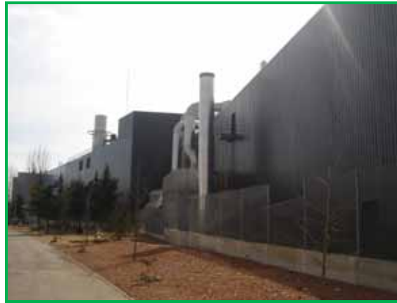
14. Tratamiento de aires (biofiltro/RTO)
